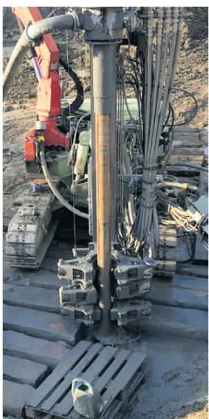
In einem vertikalen Bohrloch von bis zu 300 Meter Tiefe werden die Sonden versetzt. Die Tiefe einer Bohrung variiert entsprechend der geologischen Beschaffenheit des Untergrundes und der notwendigen Heiz-/Kälteleistung.
